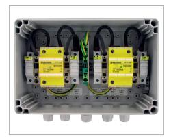
Generatoranschlusskasten mit Sicherungshaltern zur Aufnahme von DC-Stringsicherungen auf der Plus- und Minusseite. Bei PV-Anlagen zum Schutz der Wechselrichter mit zwei MPP-Trackern.
