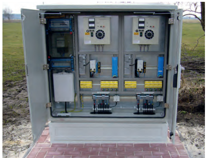
Schutz einer Gleichrichterstation (LAF Brachwitz)
