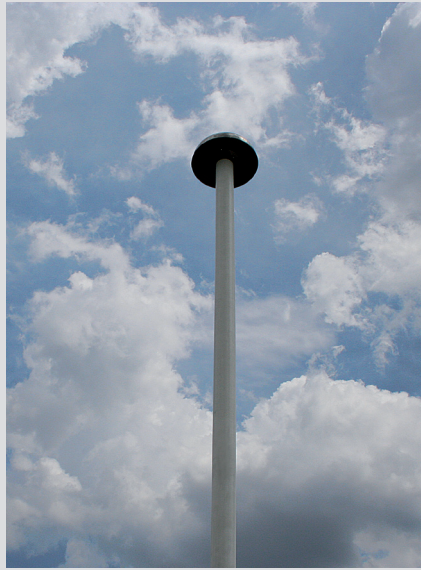
Blitzschutz vom Nachbargebäude aus
