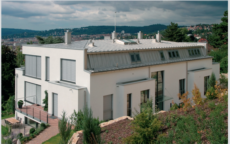
Blitzschutz nach Klasse 2 – mit nur einer Fangeinrichtung und einer Ableitung, die durch die Villa führt (weitere Beispiele: www.leutron.de/aeusserer-blitzschutz.html )
